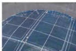
در بعضی نقاط که دسترسی جهت انجام امور وجود ندارد ، می توان از توری ها به عنوان پلتفرم در زیر پای کارگران استفاده کرد ، بدین صورت که شبکه توری ها بصورت توری استاتیک نصب و متصل می گردند و افراد می توانند بر روی توری ها راه رفته و بصورت کاملا ایمن به انجام امور بپردازنند.
